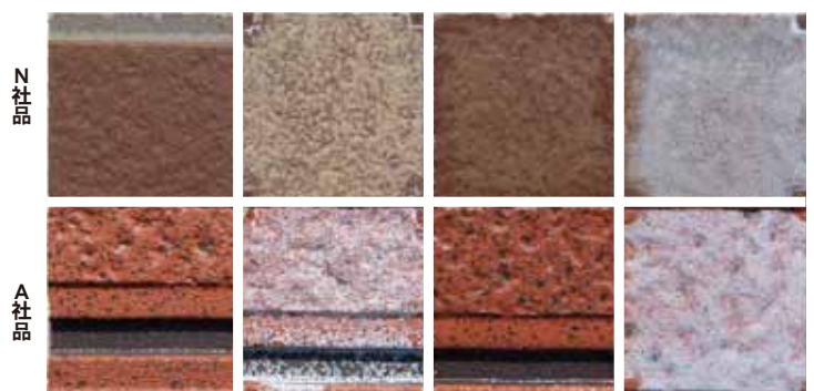
図3 S-UV促進試験800時間後の外観状態
