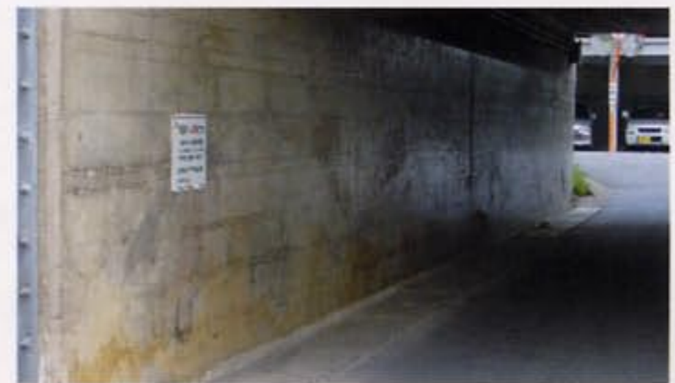
地下道モルタル面の保護クリヤー
