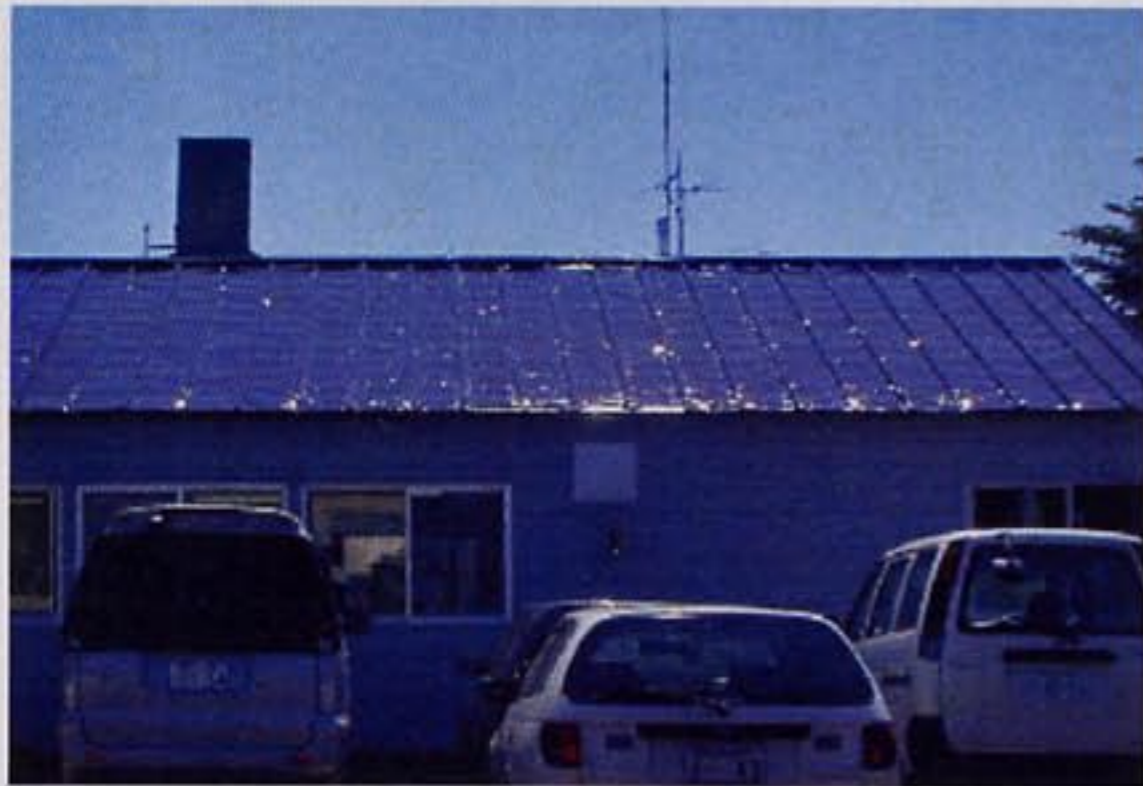
●アレス屋根遮熱システム(左側半分)と一般の屋根用塗料を塗装した物件
