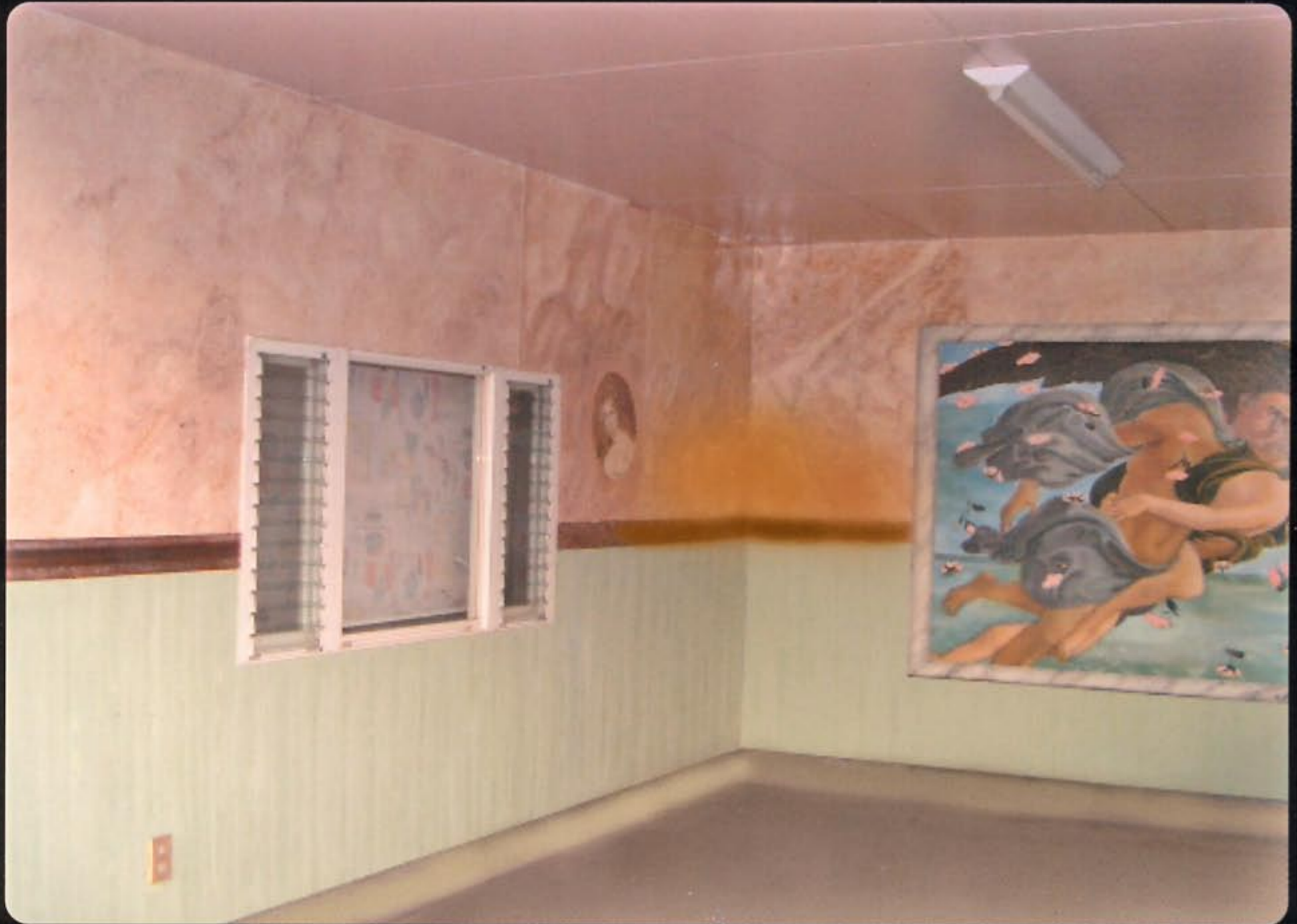
施工例：木目調仕上げ(腰壁部)
